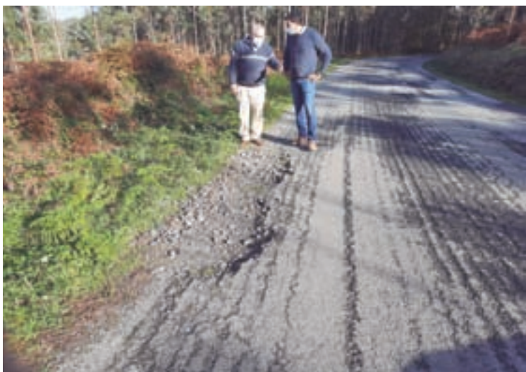
Supervisión do alcalde á estrada de acceso á praia de Xilloi
