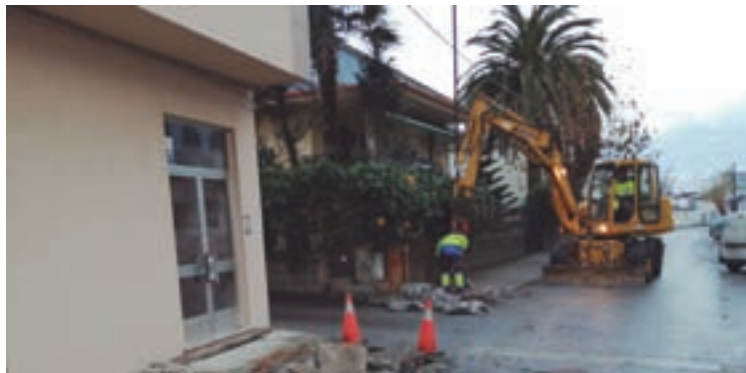
Unha imaxe das obras en Vilaselán
