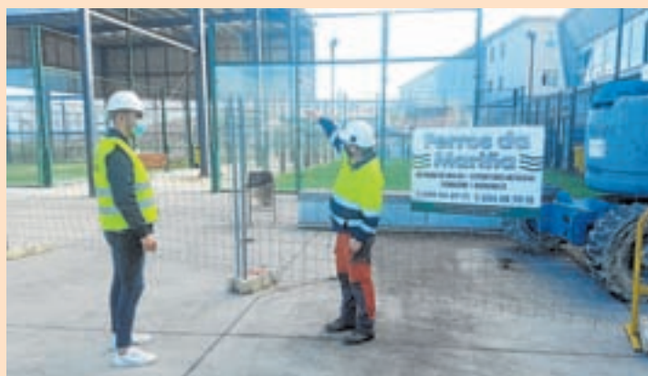
Imaxe de arquivo do inicio das obras da pista de pádel
