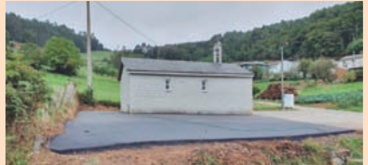
Obras rematadas en Val
