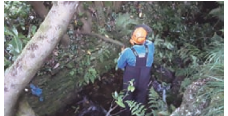
Tarefas de limpeza no rego do Cal
