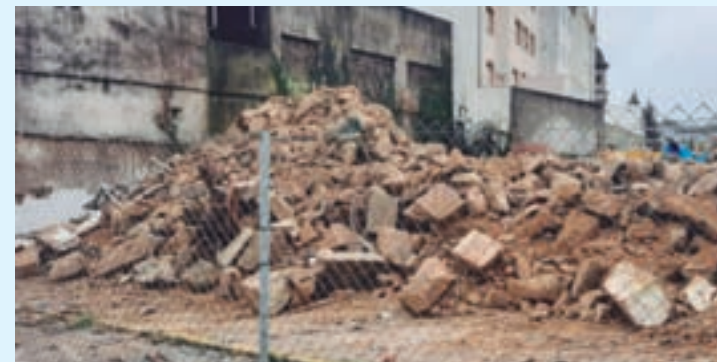
Estado no que quedou a Casa da Botica tralo derrubamento
