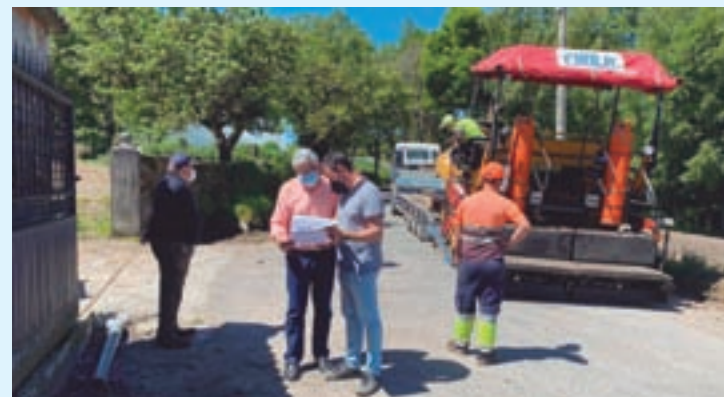
Supervisión da novas obras dos accesos
