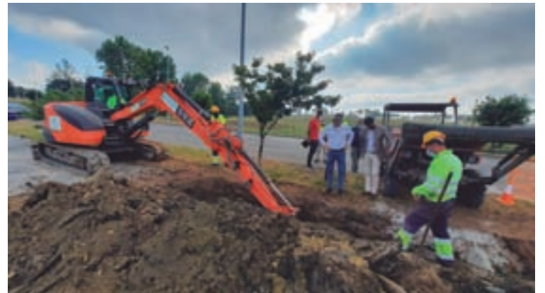
O alcalde, supervisando o inicio das obras
