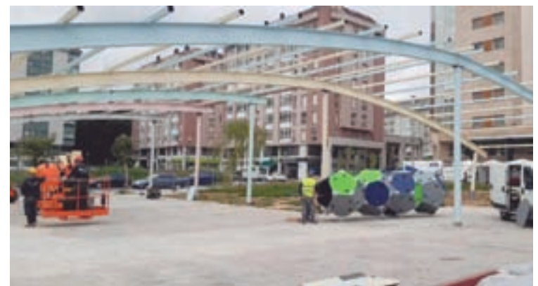
Obras do parque de Augas Férreas
