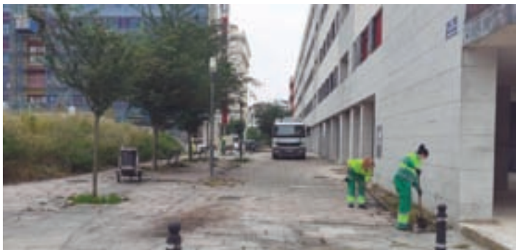
Traballos de limpeza nos barrios
