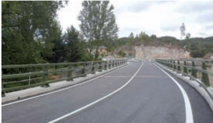
Unha imaxe da ponte, xa rematadas as obras
