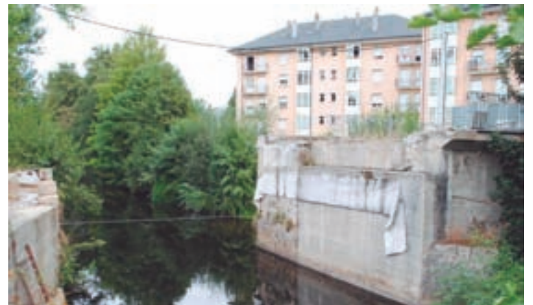
Unha vista da ponte Ribeira
