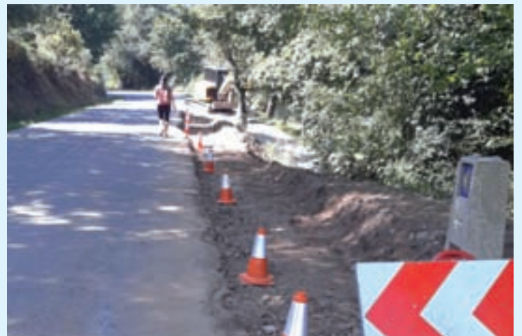
Obras de mellora do Camiño en Triacastela
