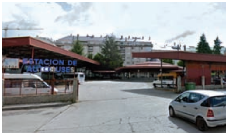
Estación de autobuses de Sarria
