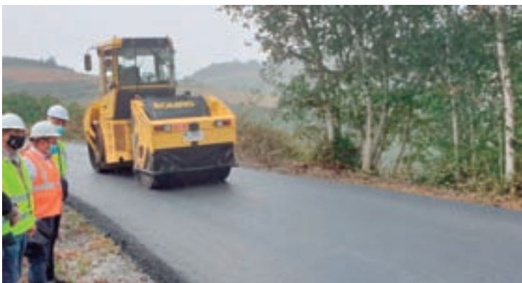
Obras no tramo da estrada autonómica
