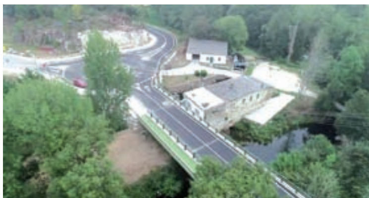
A ponte de Valdriz, unha vez rematadas as obras
