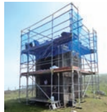
Cristo do Fiuoco en obras
