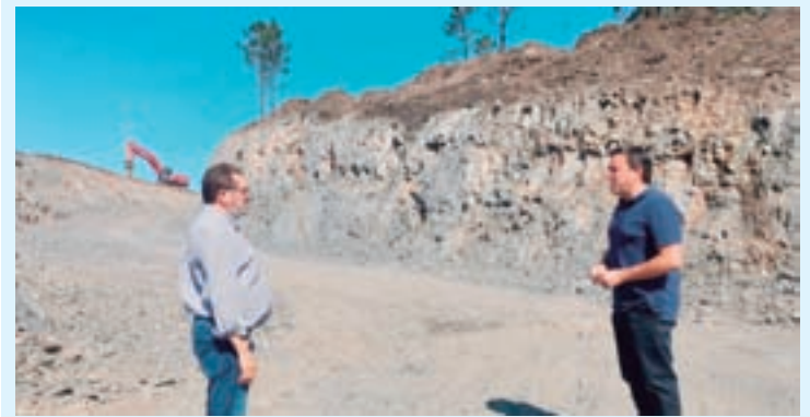
O alcalde e o concelleiro de obras, visitando os traballos
