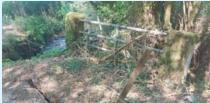
A ponte das Candelas
