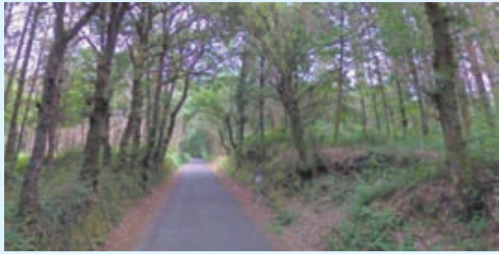
Unha vista da estrada que une as dúas localidades
