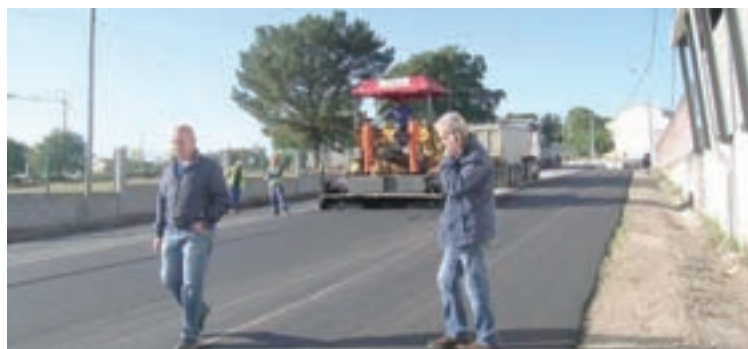
Visita do alcalde ás obras
