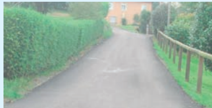
Estado dos novos vias
