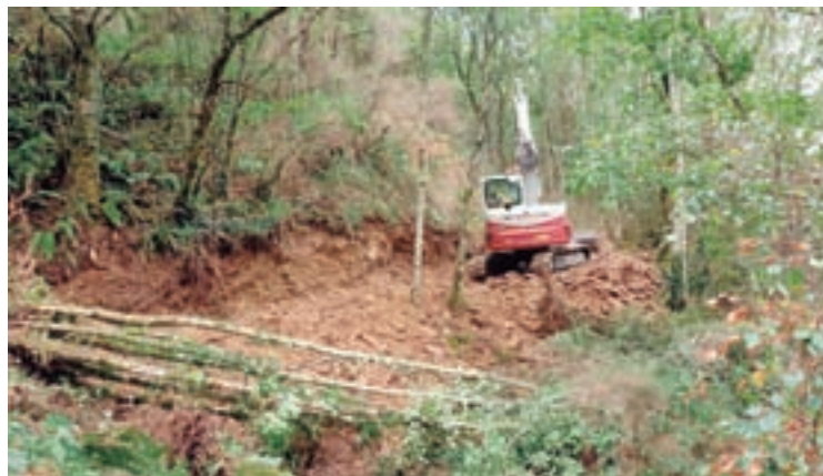
Máquina traballando no desbroce para a construción da tirolina
