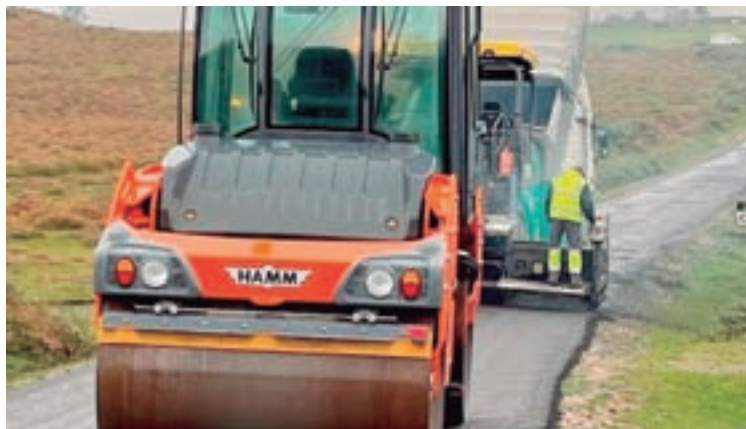
Máquinas traballando en Oourol
