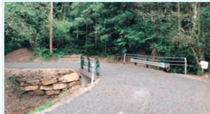
Imaxe da ponte de Paxarín tras as obras
