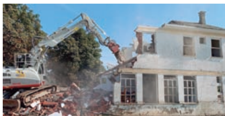
Obras de demolición en Cedofeita
