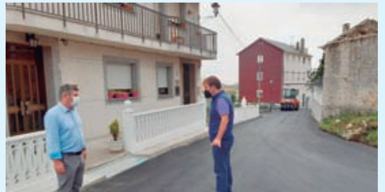
Visita do alcalde á rúa unha vez rematadas as obras
