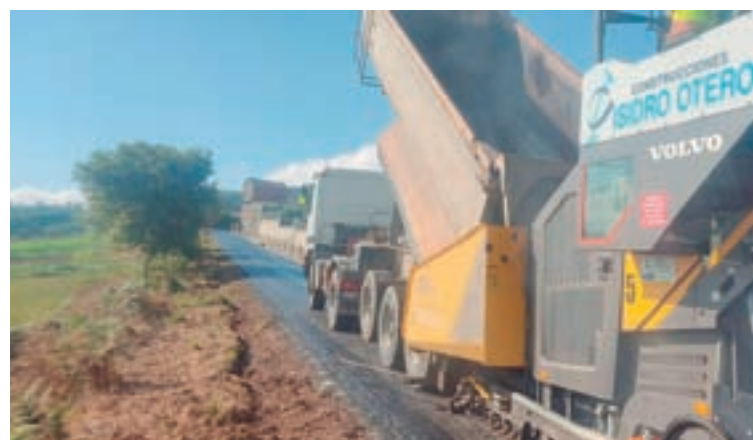
Obras de mellora na estrada de Barreiros
