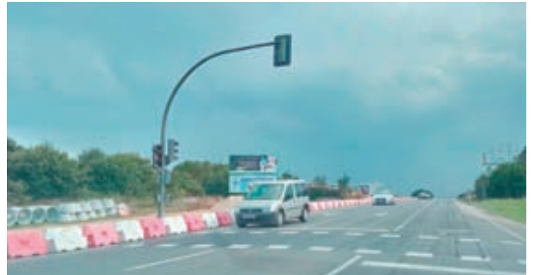
Traballos de desdoblamento da avenida
