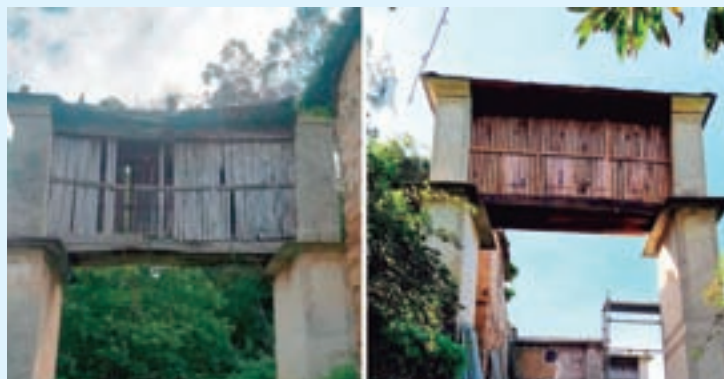
O antes e o despois do traballo de rehabilitación
