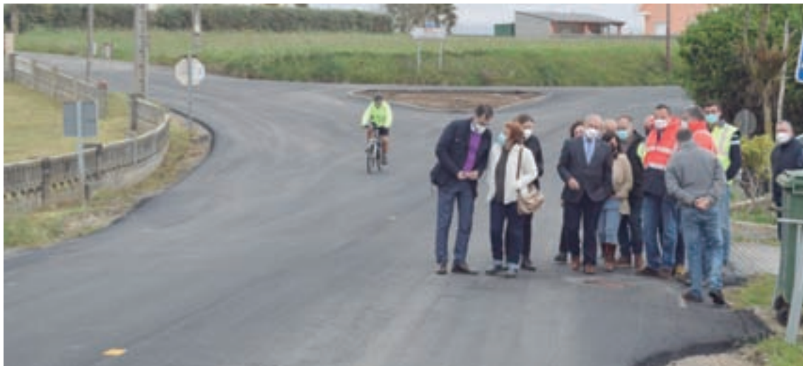
Supervisión dos traballos na estrada de Barreiros ás praias
