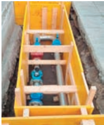
Instalación dos novos equipos
