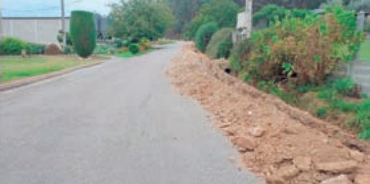
Obras en Vilarbetote
