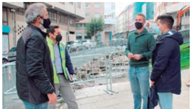
O tenente de alcalde Rubén Arroxo, supervisando varias obras, arriba no polígono das Gándaras e abaixo, na praza da Árbore
