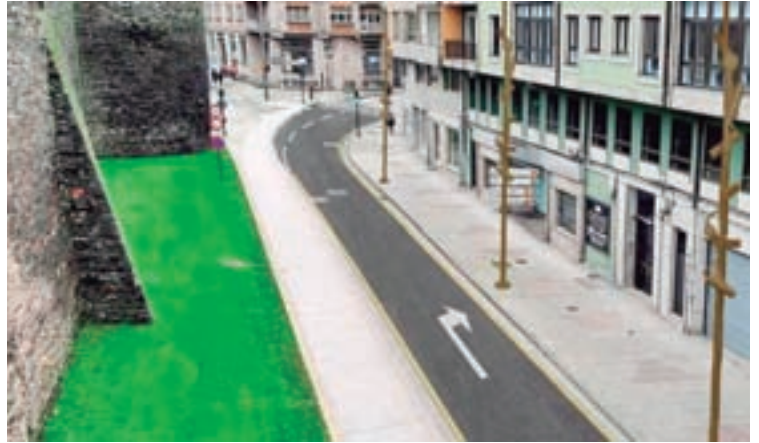
Estado no que queda a zona trala súa remodelación
