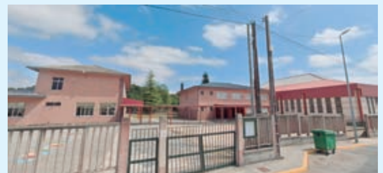
Instalacións do antigo colexio de Baamonde
