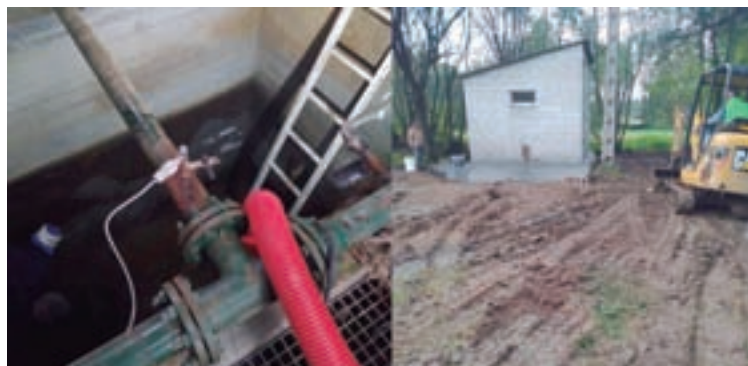
A estación de Vián, no interior e exterior, durante as obras
