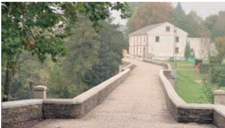
A ponte medieval, trala súa remodelación
