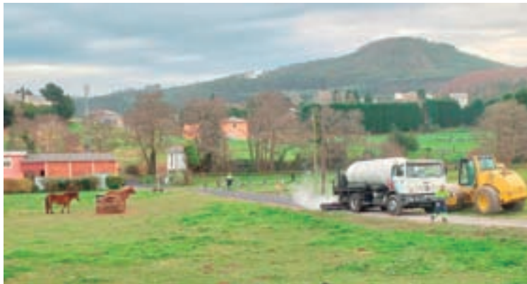
Asfaltado en Cangas, Vilaronte e Nois
