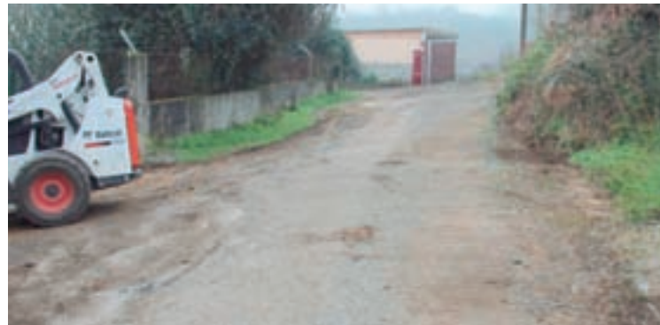
Traballos na rúa da Brétema da Ponte
