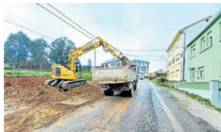
Rúa Limoeiros (arriba) e Costa Castro, en obras
