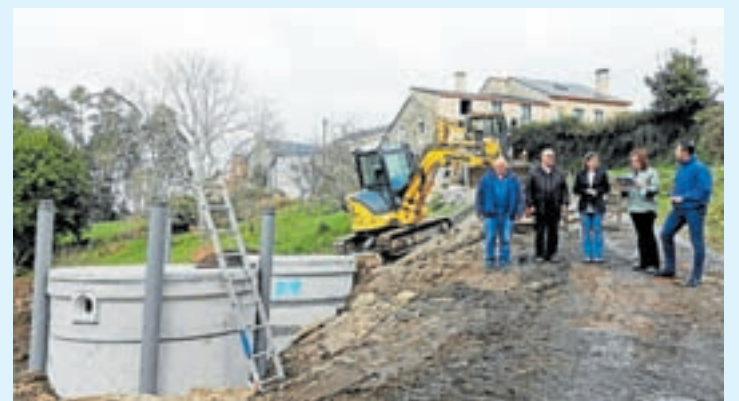
Visita ás obras de Vilastrofe
