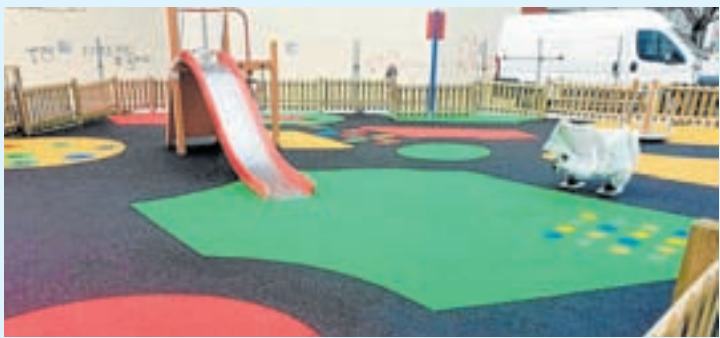
PARQUE INFANTIL. Remataron as obras de mellora e renovación do parque infantil da Avenida das Américas, logo de que se colocara un novo pavimento de caucho en todo o perímetro, así como a instalación dun novo xogo para as nenas e nenos máis pequenos. Trátase da primeira área de xogos infantís da cidade que conta cun pavimento destas características e marcará unha liña a seguir para futuras intervencións.
