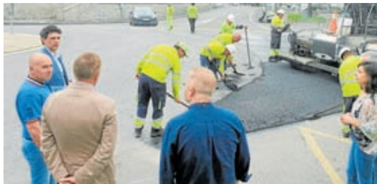
O alcalde e o delegado da Xunta, supervisando as obras
