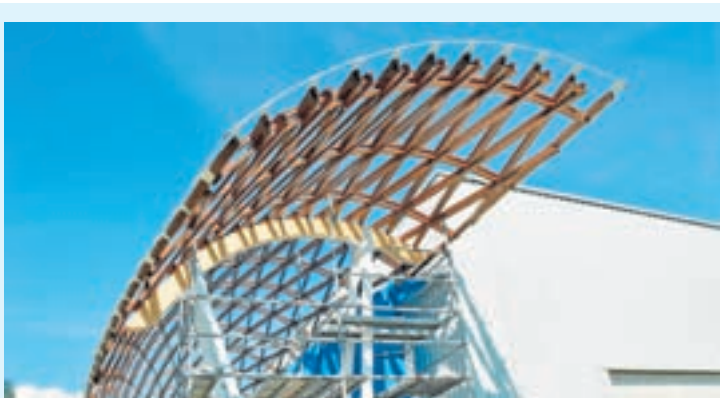
PREMIO. A gridshell de madeira de eucalipto globulus deseñada e construída pola Plataforma de Madeira Estrutural (Pemade) da USC nun dos pavilións da Escola Politécnica Superior de Enxeñaría do Campus Terra vén de recabar un accésit na última edición dos premios Margarita Salas de Investigación.
