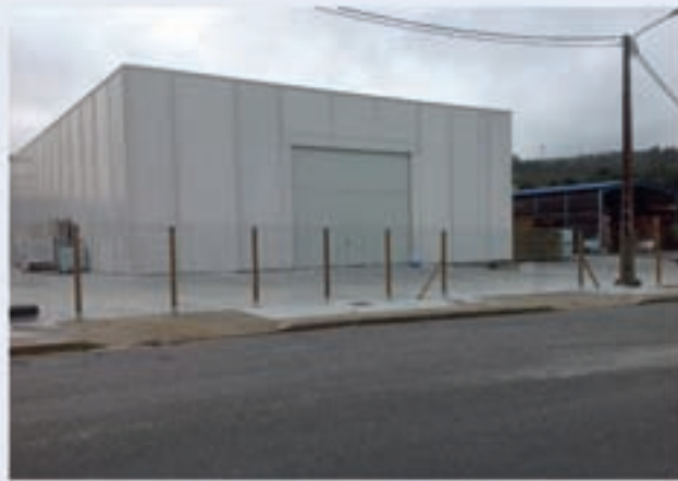
CONSTRUCCIÓN DE NAVE EN XERMADE
