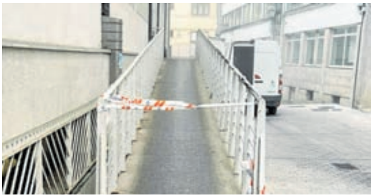
PRAZA DE ABASTOS. A Asociación Lugo Monumental denunciou que a entrada lateral da Praza de Abastos, situada na rúa Tuñas Bouzón e que conta coa única rampla de acceso ao edificio, permanece inutilizada desde o mércores pasado debido a unha avaría no sistema eléctrico da reixa automática que a pecha.
