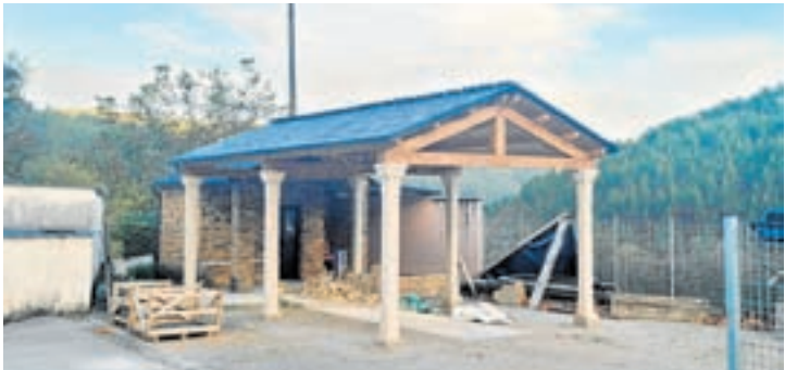
Riotorto vén de completar unhas obras de mellora no campo de bolos de Santa Marta de Meilán, unha instalación moi utilizada polos veciños e polo Club de Bolos Cruceiro de Meilán, que é o equipo local que compite habitualmente neste espazo.
