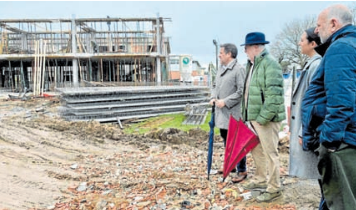
Comezo das obras de rehabilitación do edificio para acoller a residencia de maiores
